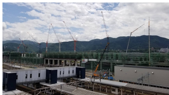
↑ 建設中の敦賀駅工事現場の様子
